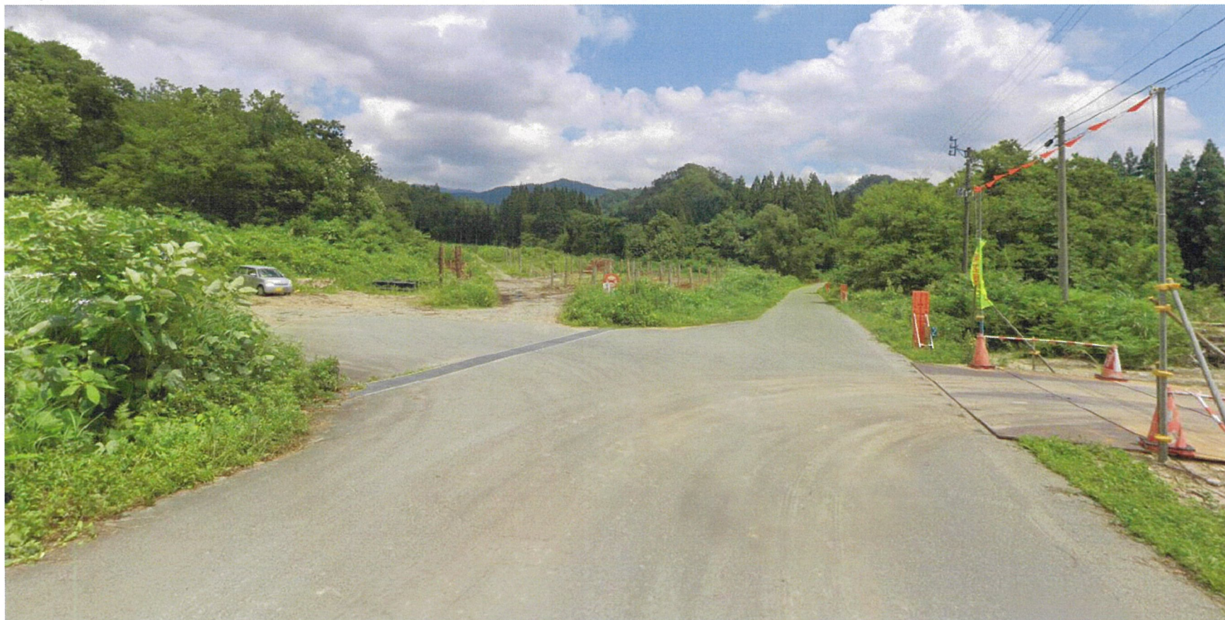
道なりに進んで道路左側に土場
