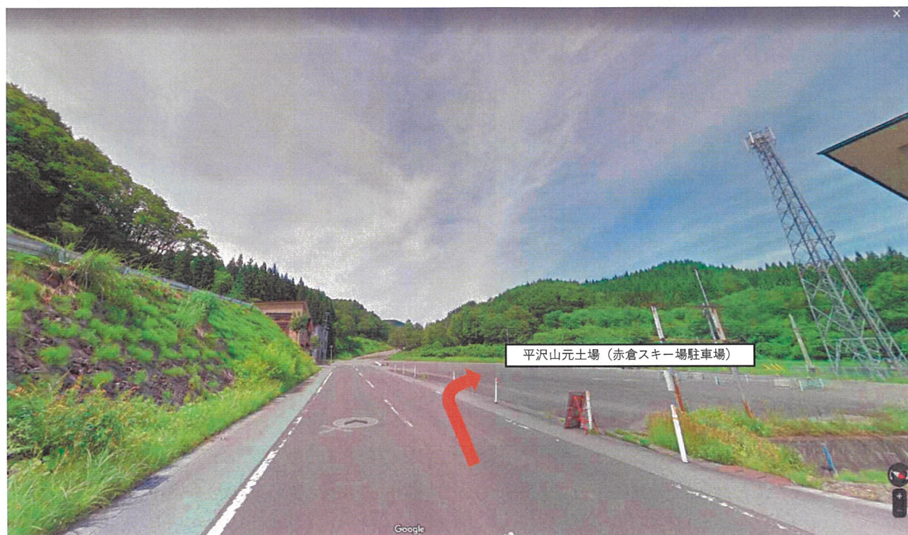
写真⑤ 2.8km先右側に平沢山元土場（赤倉スキー場駐車場）
